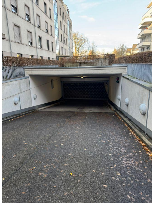
Einfahrt Tiefgarage Nachbargebäude
